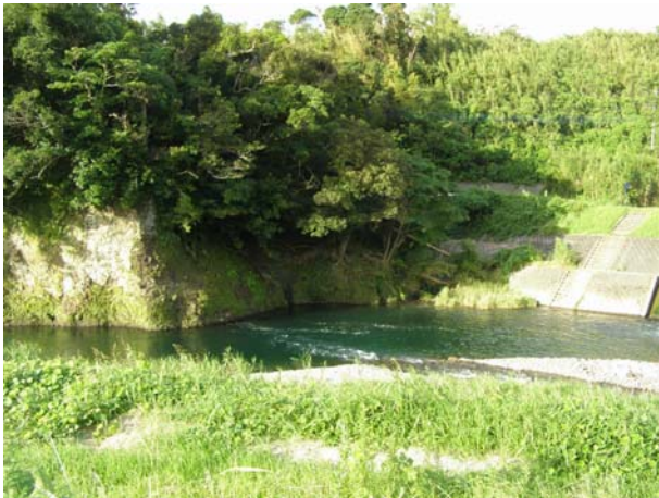
写真 2.2.32 支川始良川（淵）
