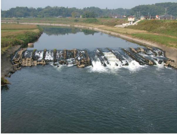
写真 2.1.8 床止め (宮下床止：肝属川本川)
