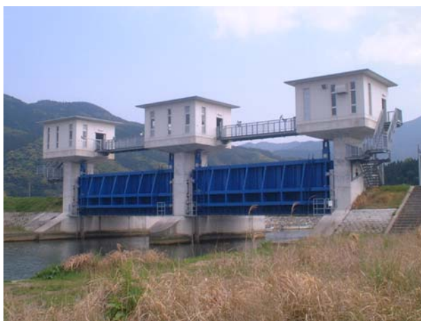
写真 2.1.2 波見水門（平成 16 年度完成）
