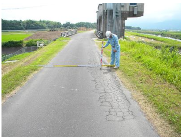
写真 2.1.7 堤防天端舗装の補修前・後
