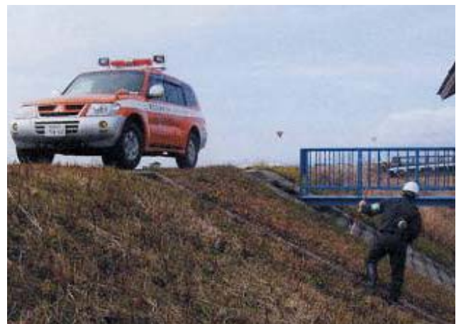
写真 2.1.6 除草実施後の点検状況
