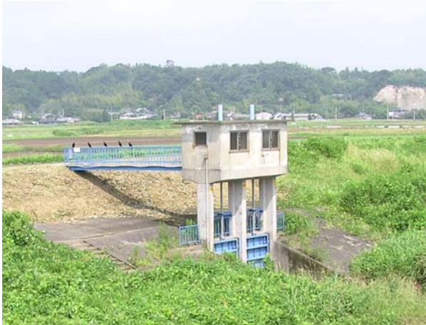
写真 2.1.10 樋管 (中郷第3 樋管：支川串良川)
