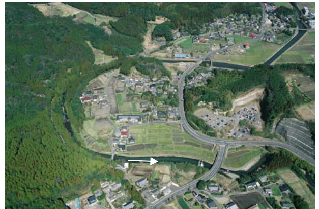
写真 2.2.1 肝属川本川上流部
