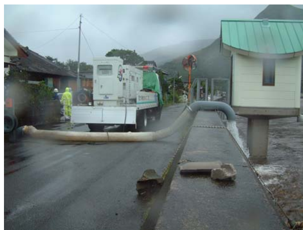
写真 2.1.3 排水ポンプ車による内水排除
